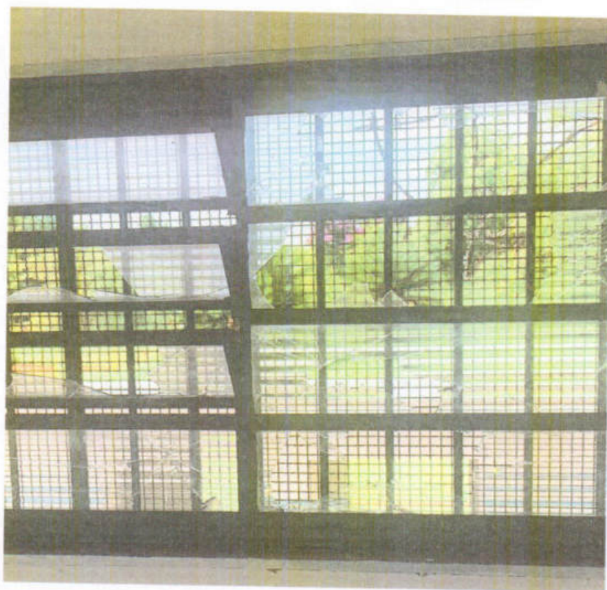
Fotos 4 e 5: Vitrô com vidros danificados e detalhamento.
