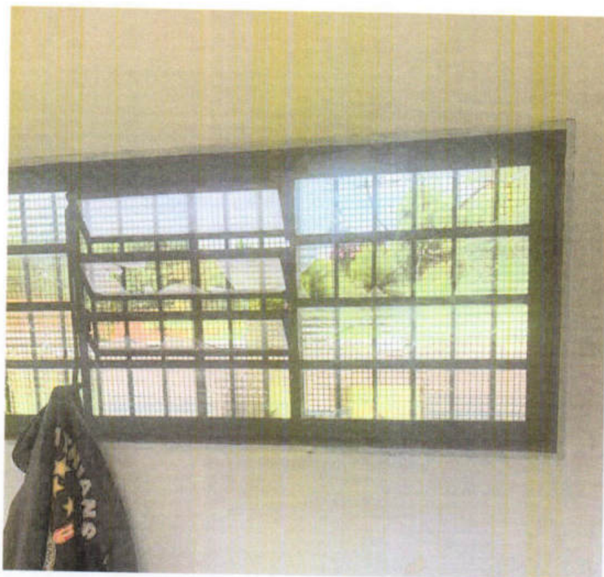
Fotos 4 e 5: Vitrô com vidros danificados e detalhamento.
