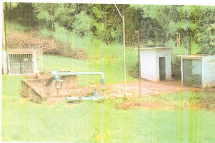
Foto 2: Ausência de bomba, sanitário sem porta e louças destruídas.
