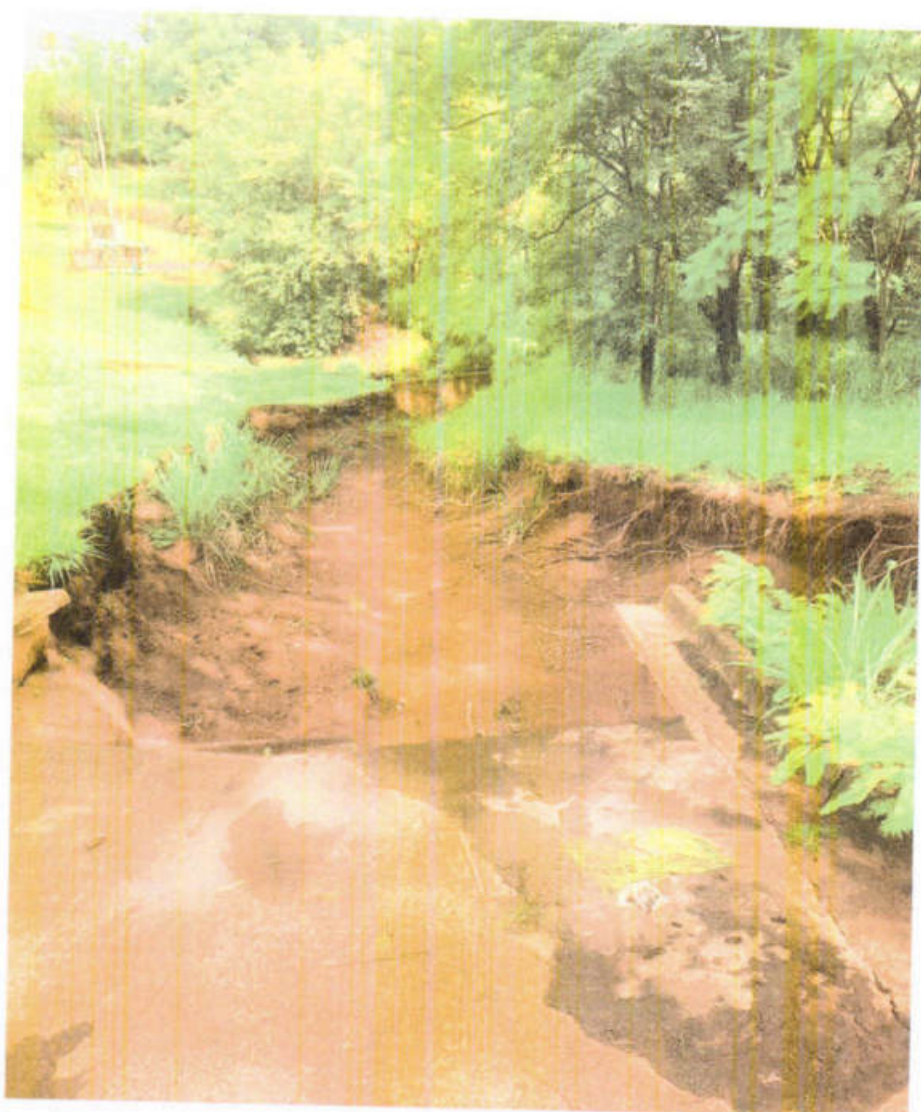
Foto 6: Danos do vertedouro. Próximo de completar 1 ano sem recuperação.
